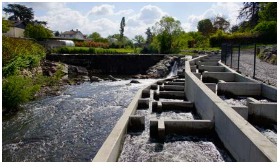
Passe-à-poissons au Seuil des Peupliers.
