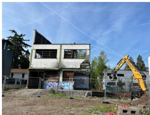
Démolition du bâtiment « bureau d'études »
